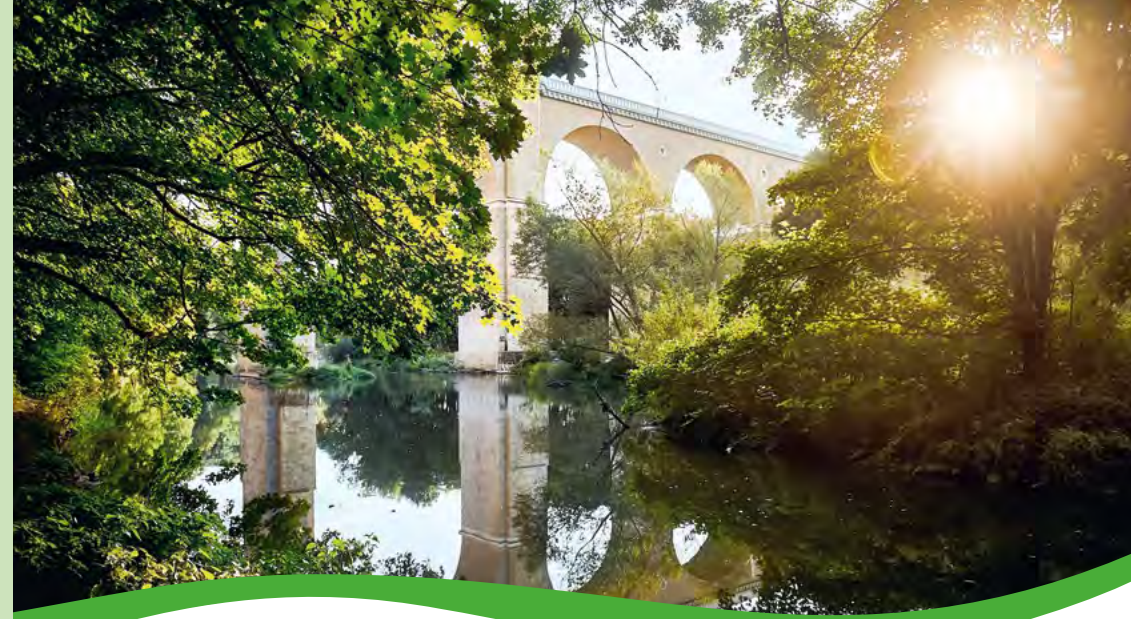
Weißviadukt in Görlitz
